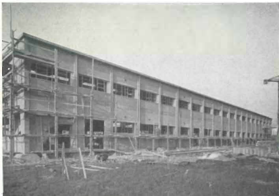
Fig. 2 - Il nuovo stabilimento in fase di completamento, copre una superficie di 3,500 m 2 . In esso saranno sistemate le linee di montaggio dei ricevitori per radio.
